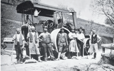
Teerung der Strasse unterhalb des Schwand/ Münsingen, ca. 1927 (Quelle: P. Stettler/P. Wälti: Der Verkehr als Triebfeder der Entwicklung, S. 419 ff., in: Münsingen- Geschichten und Geschichte
